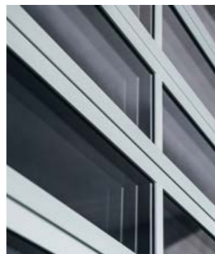
Standard: Thermisch getrennte 3-fach DURATEC-Verglasung mit Glashalteleisten
